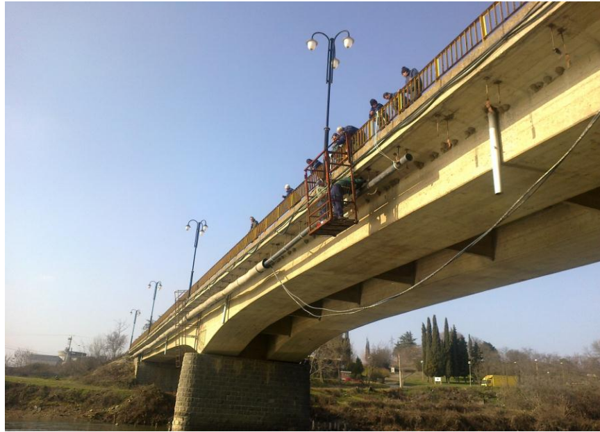
Сл. Поправка на регионален водовод ПВЦ 225 мм.
