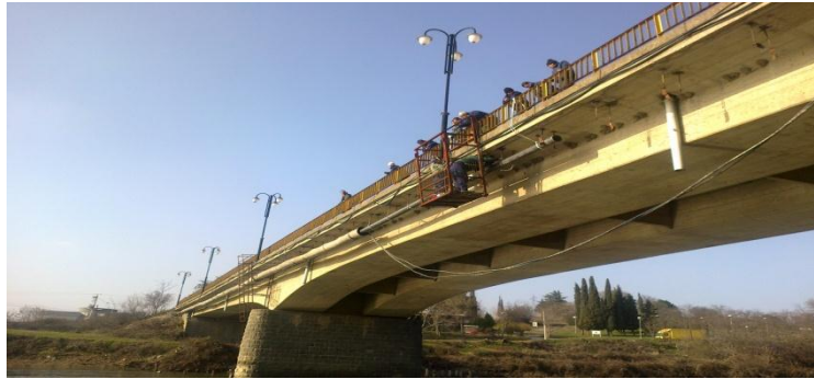
Сл.Поправка на регионален водовод ПВЦ 225 мм.
